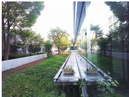
建築学科棟と新設された立ち上がり壁
