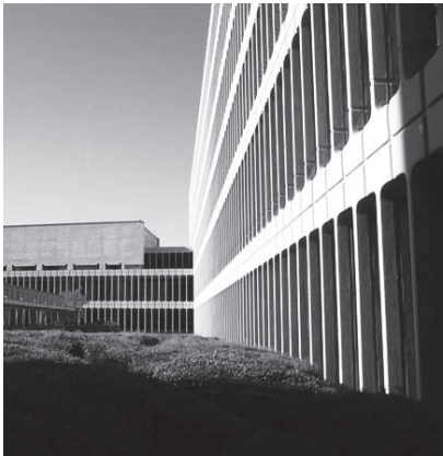
千代田生命本社ビル（現・目黒区総合庁舎）
