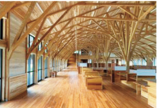
屋久島町役場：窓口棟
