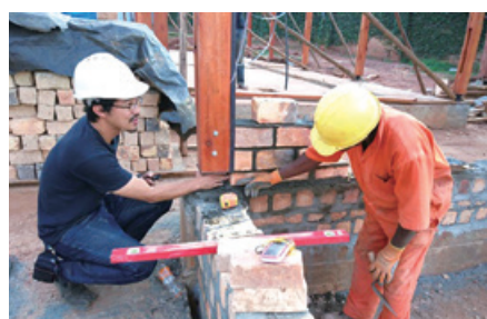
施工中の監理の様子・左が筆者
