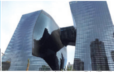
オーバスタワー・工事中（写・17）
