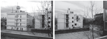
4号館屋上から旧6号館跡地、14,15号館、図書館を見る
