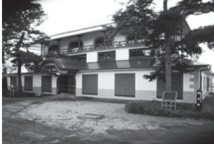
県重要文化財「開成館」修復
