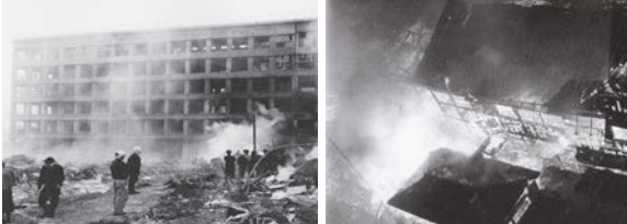
端島小学校（建設中の校舎も焼ける）
