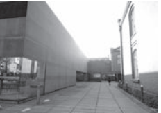
1ー⑦金沢市立玉川図書館
